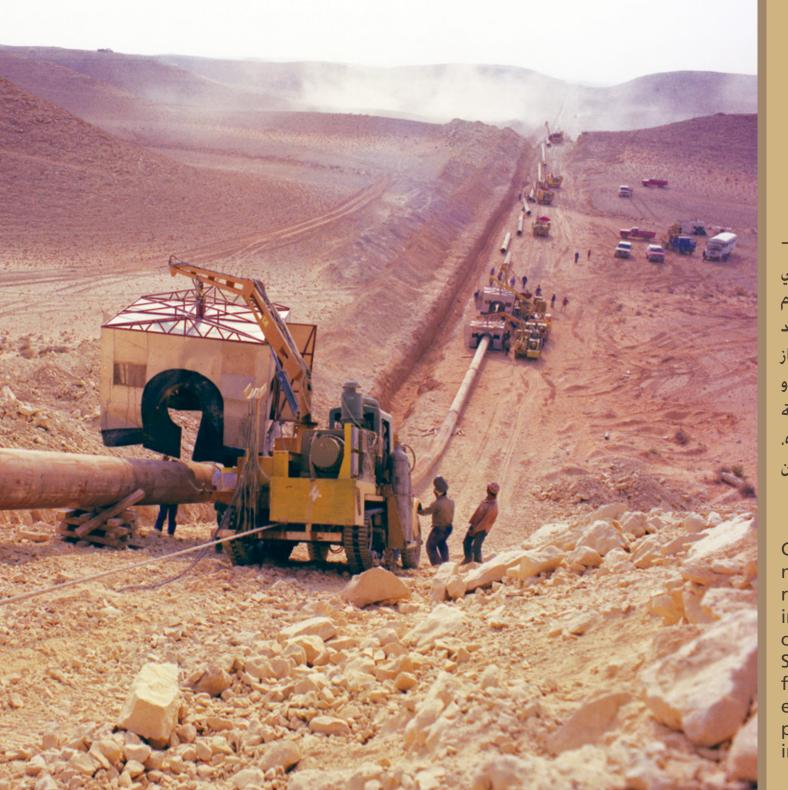
وصلت أعمال مدخط الأنابيب شرق عرب لنقل سوائل الغاز الطبيعي ألى موقع بنبان، قرب الرياض عام 1979. وكان هذا الخط هو أحد المكونات الأساسية لشبكة الغاز الرئيسة، المصممة لتوفير الوقود أو اللقيم المستخدم في توليد الطاقة الكهربائية المحلية، وخلية المياه، وإنتاج البتروكيماويات وغيرها من الصناعات.
